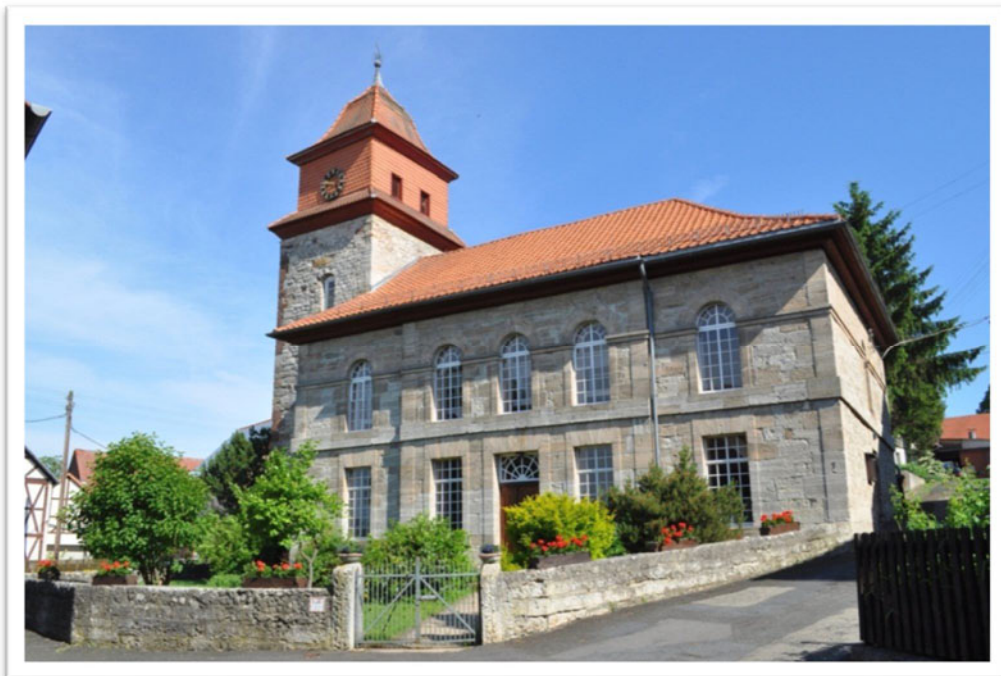
Kirche aus behauenen Kalksteinen, die hier überall zu finden sind (erbaut im 17 Jahrhundert)
